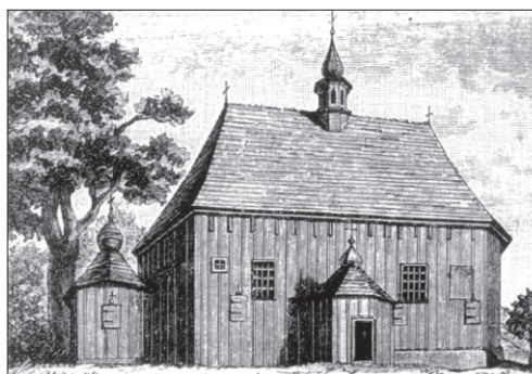
6. Kościół w Czarnym Potoku. Stan sprzed rozbudowy w latach 1904–1906. Arch. Parafialne
