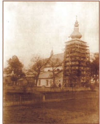
Remont kościoła w Łącku, kaplica MB Częstochowskiej w budowie lata 30ste XX wieku
