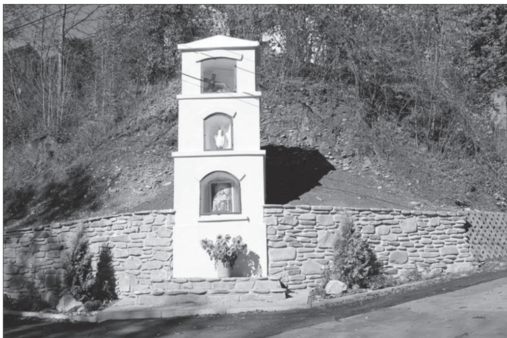
Kaplica w Zabrzeży po renowacji, 2012 r.
