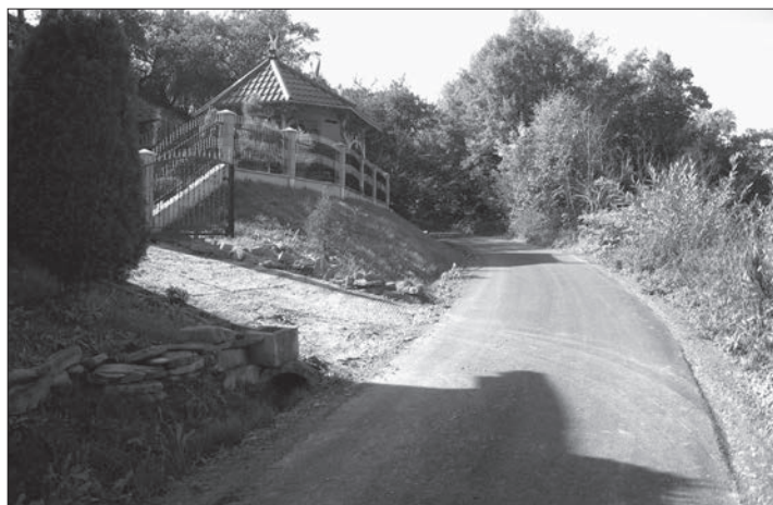
Odbudowa drogi – Brzyna
