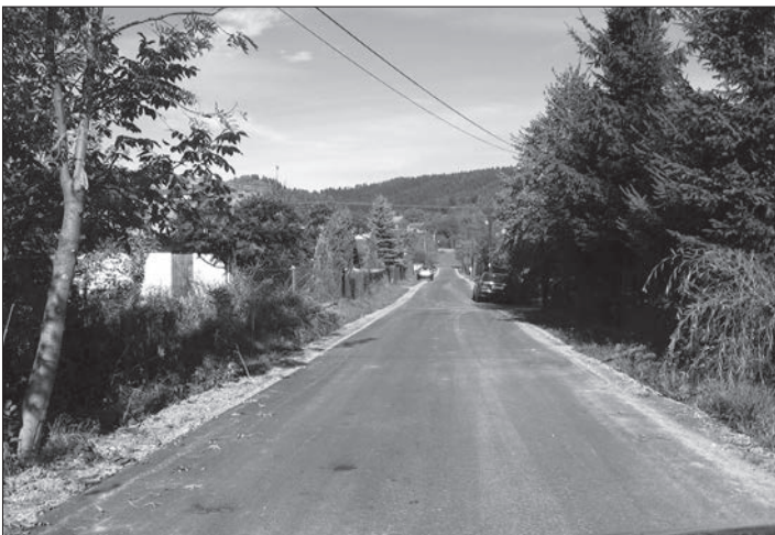
Odbudowa drogi – osiedle w Jazowsku
