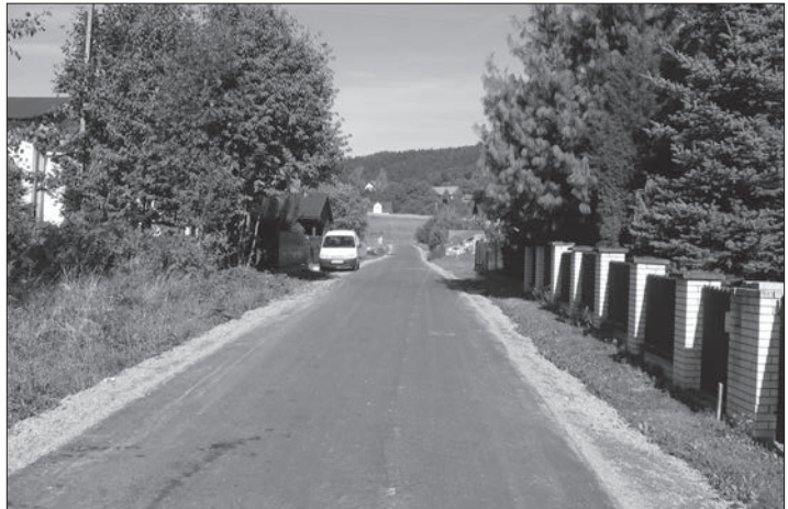
Odbudowa drogi – osiedle w Jazowsku
