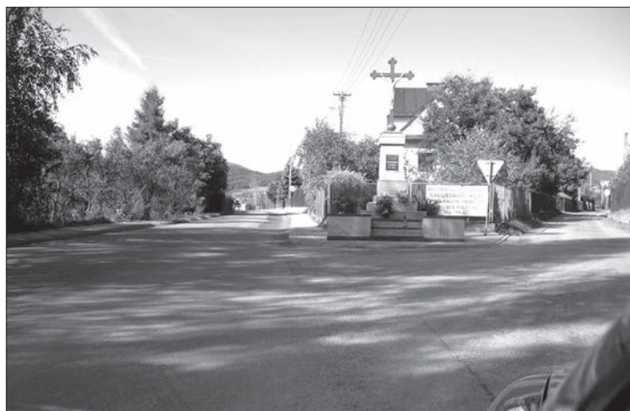
Budowa chodnika w Łącku
