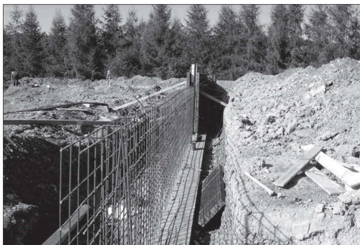
Budowa boiska Orlik
