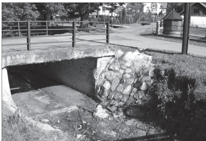
Odbudowa podpory mostu Maszkowice
