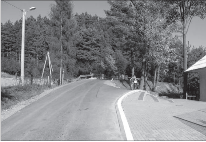
Odbudowa mostu w Kadczy
