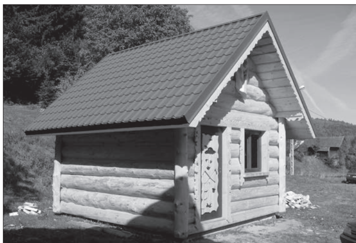
Budynek przy amfiteatrze
