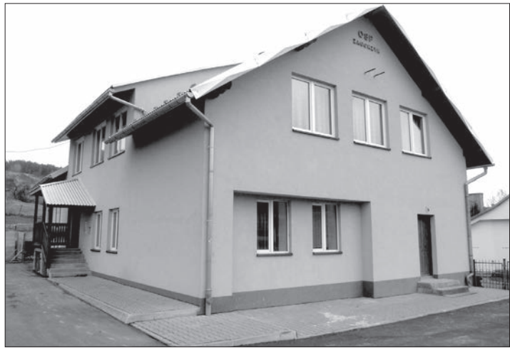
Budynek remizy OSP w Zagorzynie
