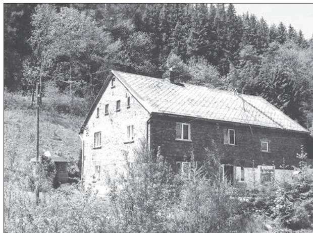
Dom Antoniego Kurzei w Jarkowicach na Ziemiach Odzyskanych
