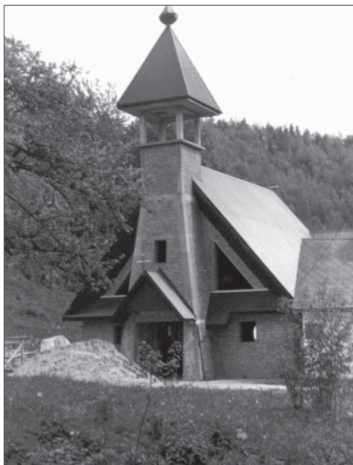
Budowa nowej kaplicy w Brzynie
