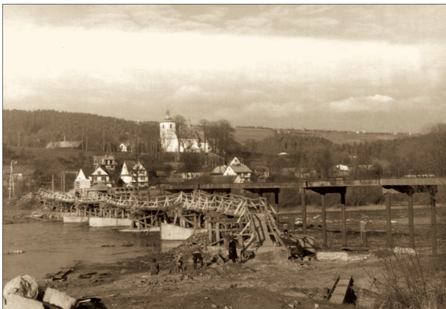
Jazowsko – budowa mostu. Ze zbiorów Wincentego Tokarza
