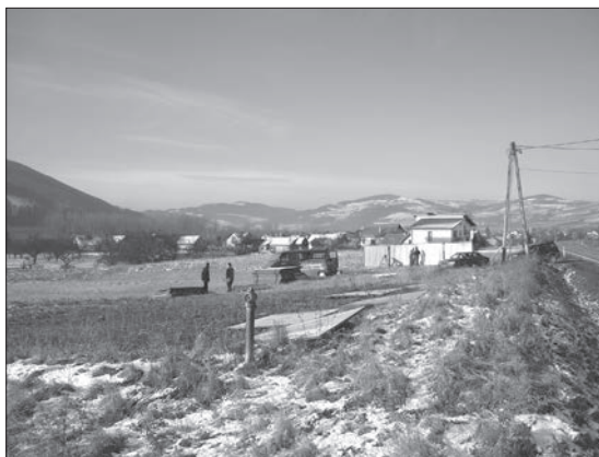
Plac budowy nowej siedziby Banku – 11 luty 2009 r.
