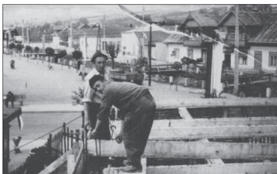
Budowa siedziby kasy w Łącku w Rynku – 1968 r.
