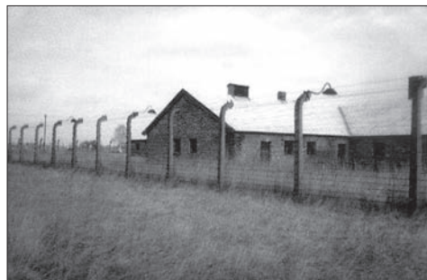
Blok w którym przebywała S. Celestyna. Oświęcim – Brzezinka
