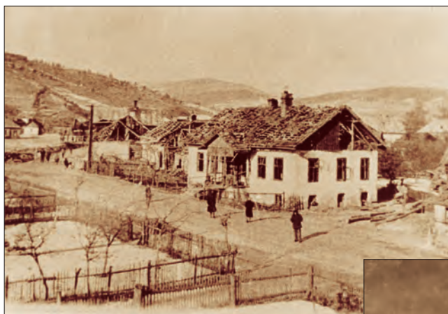
Zniszczenia po wysadzeniu mostu przez uciekających Niemców w styczniu 1945 r. (fotografia ze zbiorów TMZŁ)
